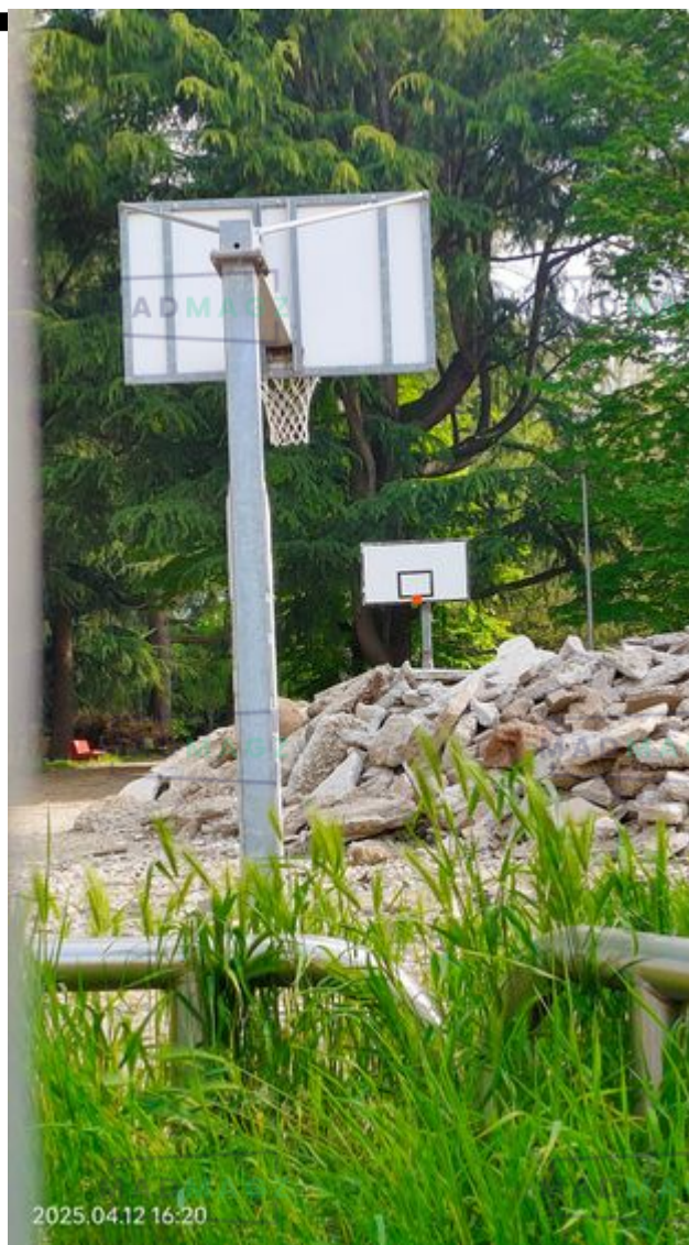
I lavori nel parco Cabassina visti dal giardino della scuola: da gennaio scorso si assiste a un "via vai" di ruspe, camion, operai. La fine dei lavori è prevista nel 2026
